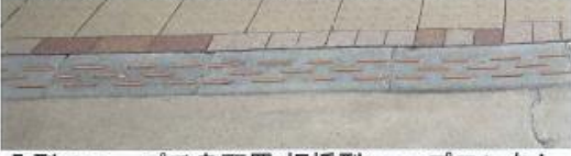
凸型スロープ千鳥配置(板橋型)×エプロンなし
