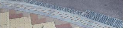
凸型スロープ千鳥配置(板橋型)×グレーチング
