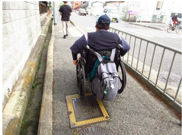
ほどう けいしゃ ちが ある 歩道に傾斜があり、すれ違いで歩くと、すぐ横の溝が気になって落ちないか少し怖かったです。
